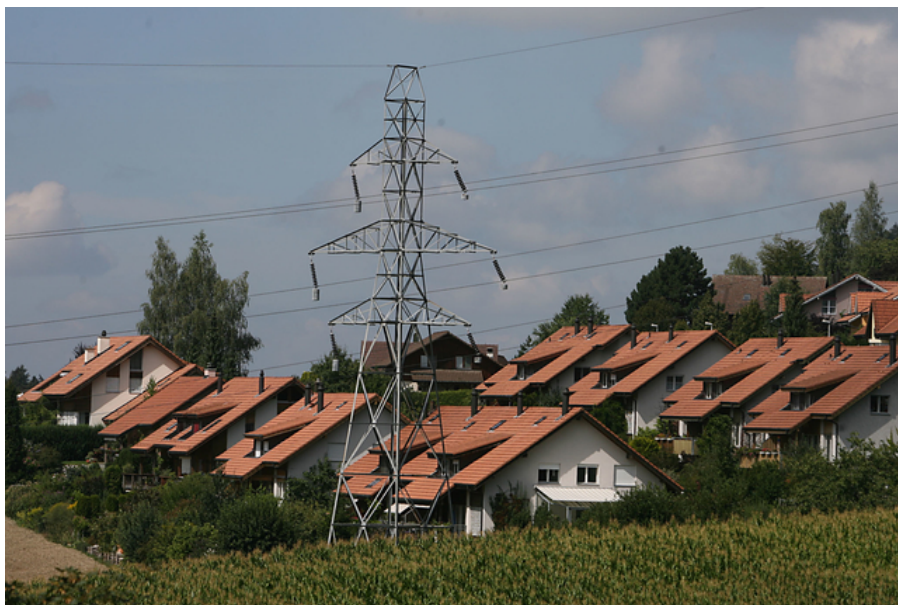
Wohnquartier in Oberscherli: Die bestehende BKW-Leitung sollte durch eine höhere und stärkere ersetzt werden. BKW und Swissgrid legen das Projekt auf Eis. Bild: Urs Baumann
