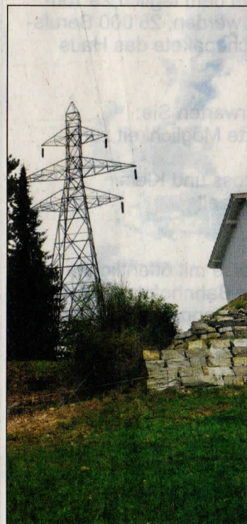
In Niederwangen soll die Leitung weiter weg von den Häusern verlaufen, verlangt Köniz. ubl
