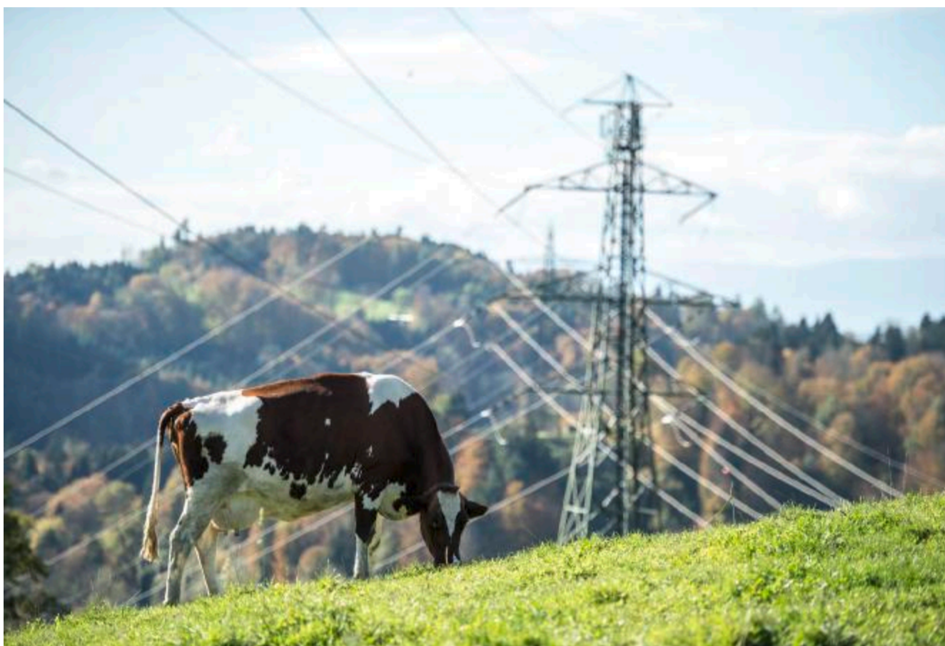
Eine Interessengruppe möchte, dass die Stromleitungen in die Erde verlegt werden. Foto: Adrian Moser
